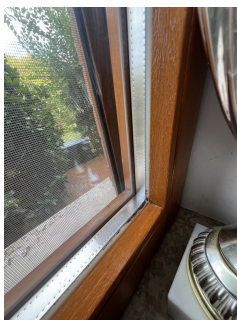
Kétrétegű, hőszigetelt fa nyílászáró
